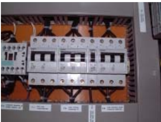
Jističe běhátek s externí skříňkou s pojistkami
