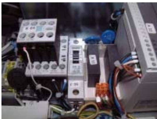
Podružný jistič – izolační transformátor s 1 fází B16A
